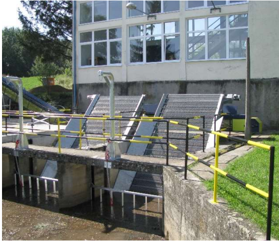
Prügyi (balra) és Felsőberecki (jobbra) szivattyútelepeken megépült uszadékfogó gerebek (Fotó: Rosvig Kft.)
