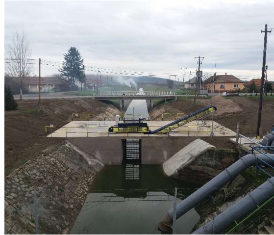
Prügyi (balra) és Felsőberecki (jobbra) szivattyútelepeken megépült uszadékfogó gerebek (Fotó: Rosvig Kft.)
